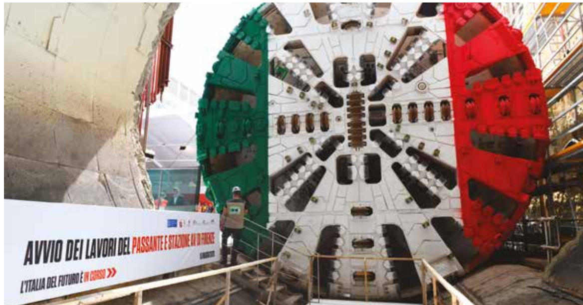
Avvio dei lavori per il Passante e la Stazione di Firenze. Start of works for the Florence bypass and station.
